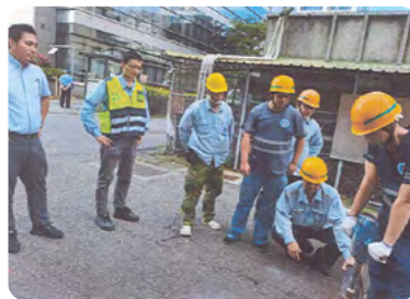
▲ OJT 教育訓練 - 鑄鐵管鑽孔
