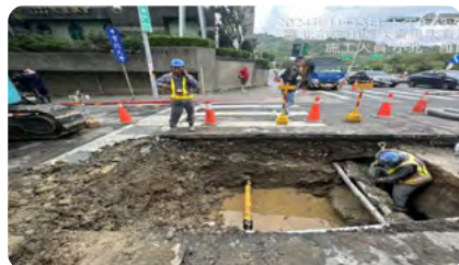
▲ 中管管線修復情況
