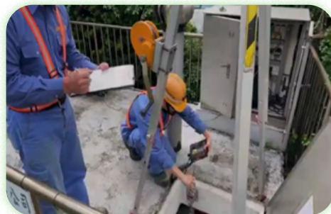
中壓人孔開關漏氣搶修演練
