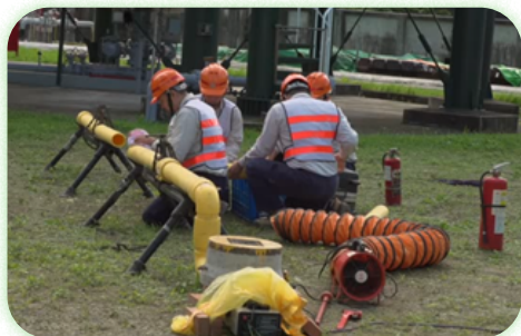
低壓 PE 管遭挖損搶修演練
