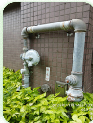
中壓管線修護完成 1883 排水後復氣
