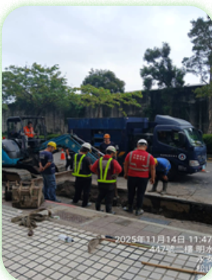
中壓管線工作班修護
