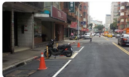
▲ 搶修完成路面修復
