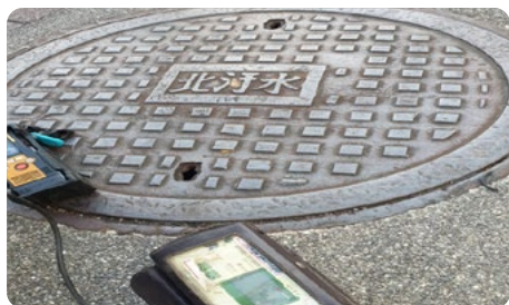
▲ 人孔巡檢測漏作業情形
