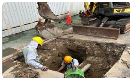
▲ 開挖修護作業情形
