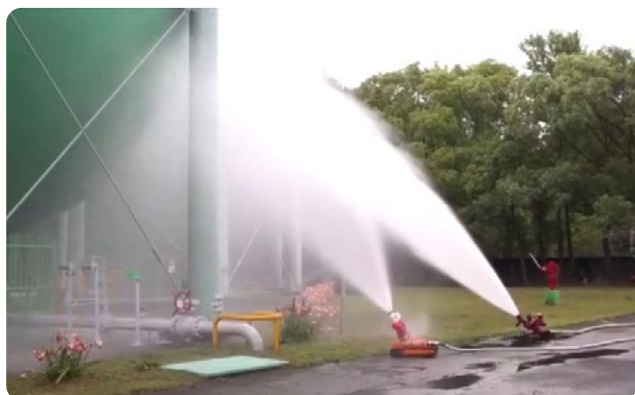
▲ 噴灑消防水柱
