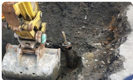
▲ 開挖修護作業情形
