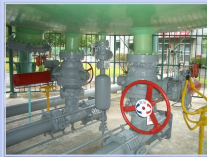
槽底伸縮管及緊急遮斷閥
