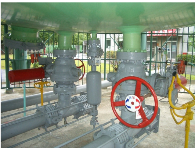
槽底伸縮管及緊急遮斷閥
