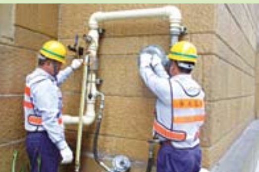
▲ 調壓器測試作業
