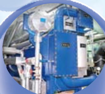
蒸氣雙效吸收式 冰水主機
