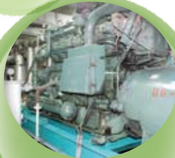
500KW 瓦斯引擎 發電機
