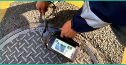
人孔巡檢測漏作業情形
