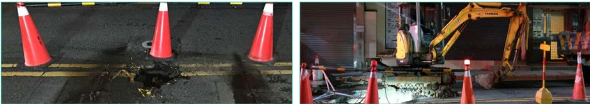
路面破損，配合新工處現場會勘開挖確認造成路面破損原因交權責單位處理
