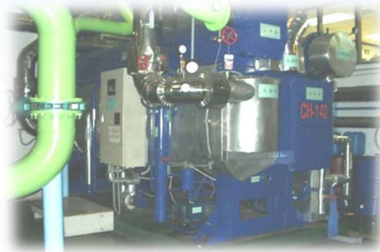
▲ 蒸汽吸收式冰水主機
